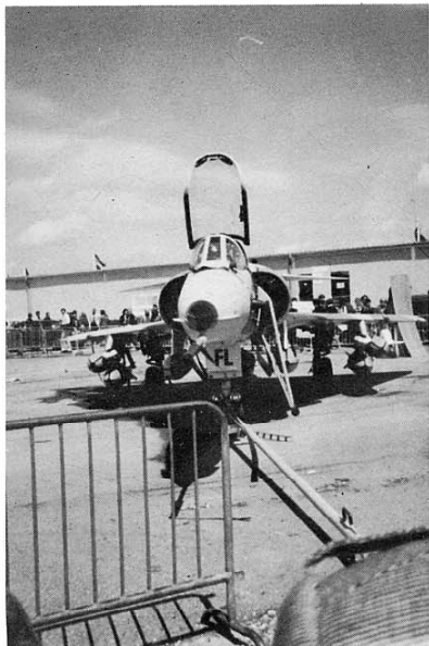
In questa immagine frontale si possono notare alcuni interessanti particolari: le due alette ai lati del muso, il doppio fano di atterraggio sulla gamba del carrello anteriore, la scritta FL sul primo portello (quello incernierato alla fusoliera) del vano relativo. (foto Benuzzi).
