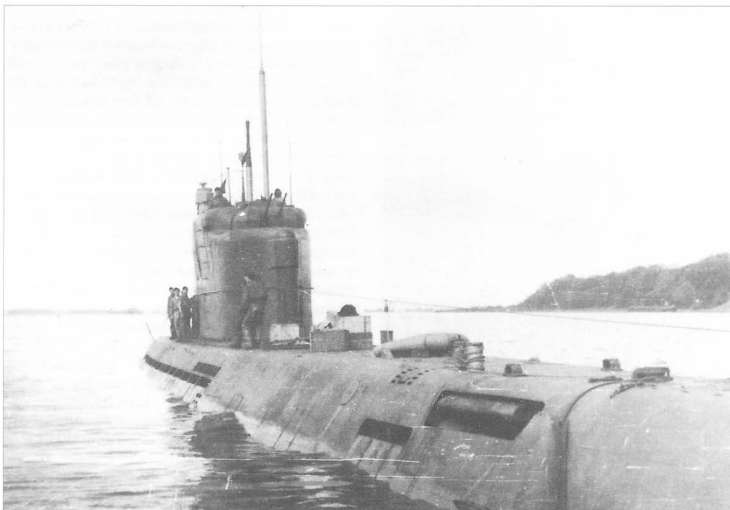
Qui a lato: U-3505. Notare i piani di profondità ripiegati nei relativi alloggiamenti e la forma arrotondata del ponte. (foto via E.Wilke)
